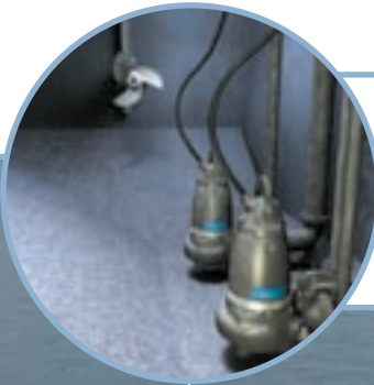
Откачка технологической воды со вторичной окалиной, образующейся при прокатке
