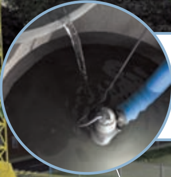
Временные обводные схемы перекачки сточных вод
