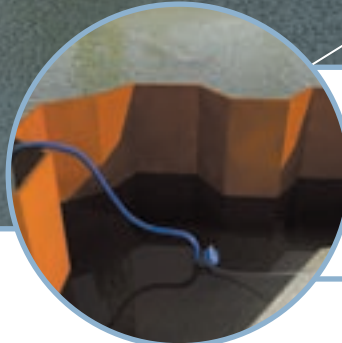
Дренаж морской воды при строительстве мостов и закладке фундаментов в портах
