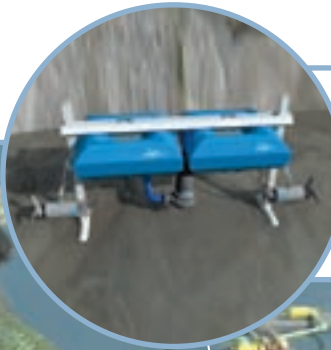
Откачка шлама из хранилища, предназначенного для аварийных ситуаций
