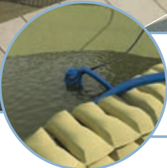
Защита от наводнений и очистные работы
